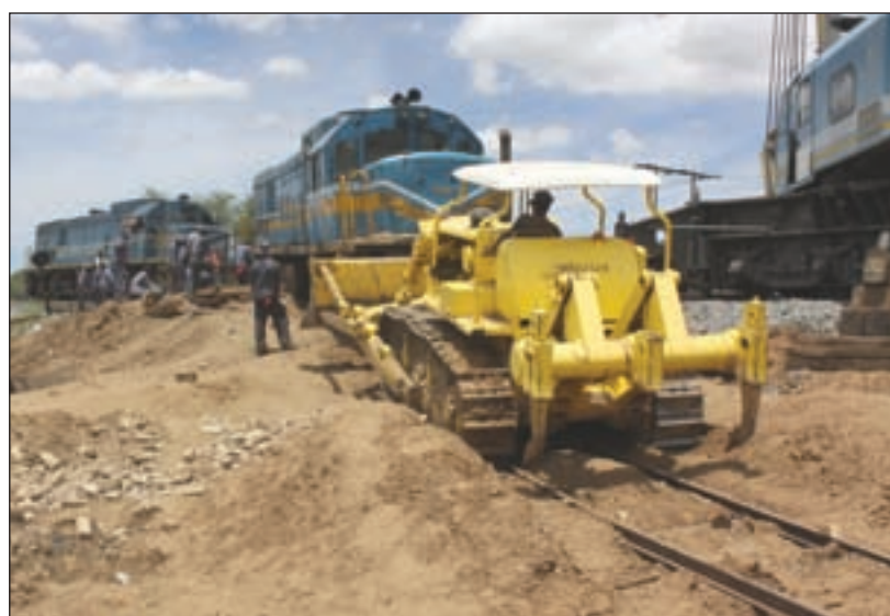
Am Wochenende zuvor war die Lokomotive schräg neben den Bahndamm auf ein provisorisches Gleis gehoben worden. Angestellte von TransNamib nutzten den vergangenen Samstag, um das Hauptgleis zu unterbrechen und mit dem neben dem Bahndamm verlegten zu verbinden. Auf diese Art und Weise konnte die erste der beiden Lokomotiven wieder auf die Schienen gezogen und nach Windhoek gebracht werden.
