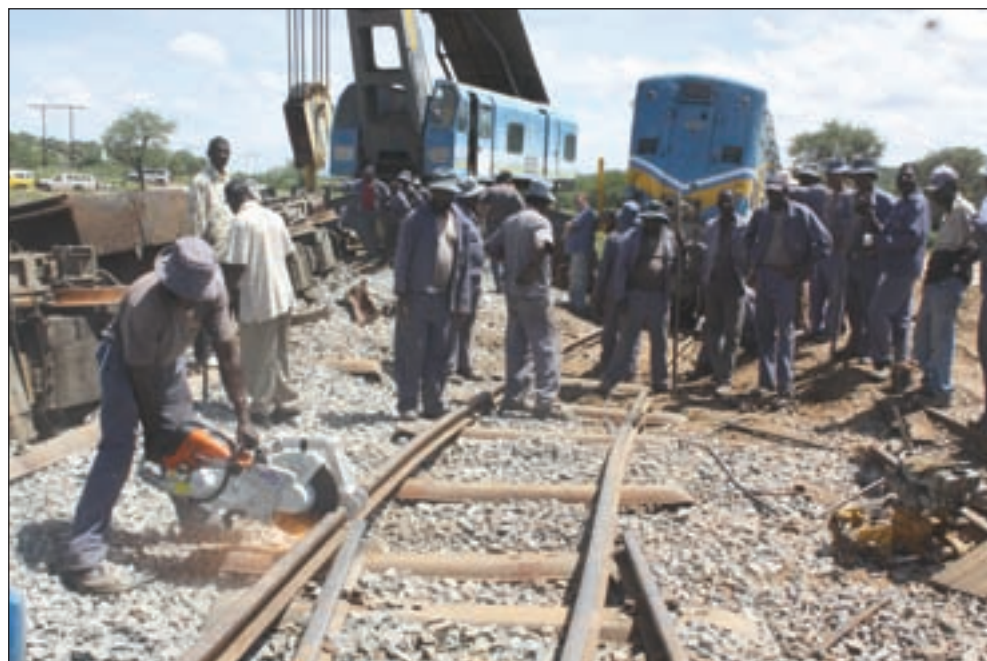
Am Wochenende zuvor war die Lokomotive schräg neben den Bahndamm auf ein provisorisches Gleis gehoben worden. Angestellte von TransNamib nutzten den vergangenen Samstag, um das Hauptgleis zu unterbrechen und mit dem neben dem Bahndamm verlegten zu verbinden. Auf diese Art und Weise konnte die erste der beiden Lokomotiven wieder auf die Schienen gezogen und nach Windhoek gebracht werden.
