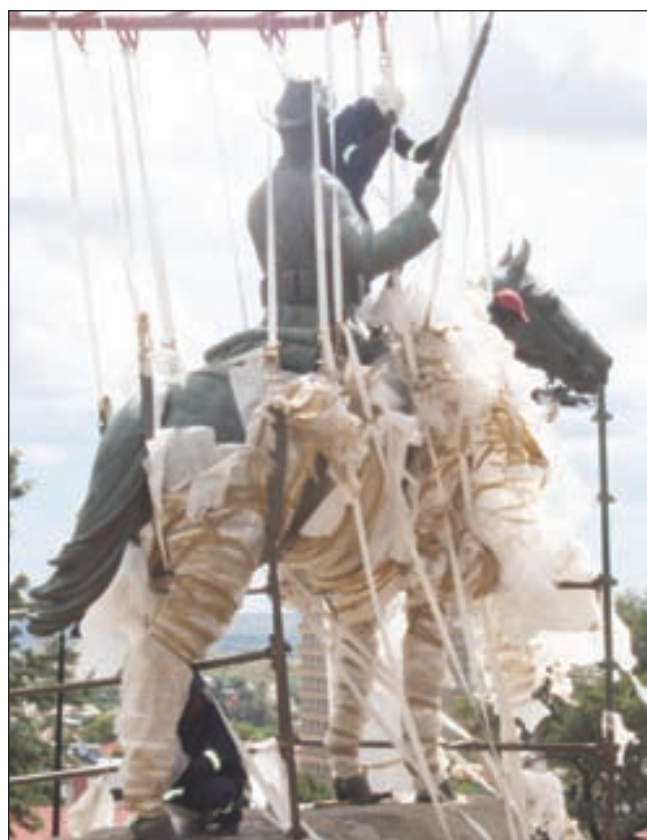
Unmittelbar nach dem Aufsetzen des Standbildes wurde dieses ausgepackt und somit wieder sichtbar.
