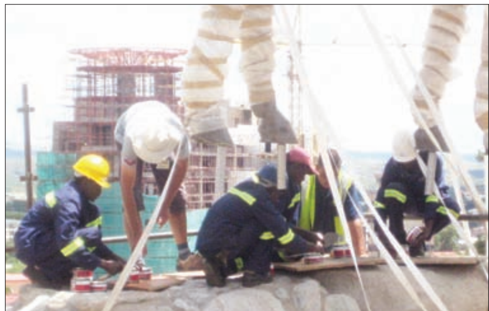
Die vier Edelstahlstifte an den Hufen des Pferdes werden in Löcher im Sockel versenkt, die mit einem speziellen Industriekleber gefüllt wurden, der schnell aushärtet.
